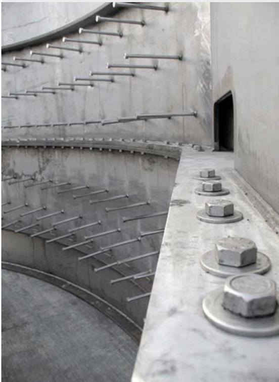
图片 6: 边线法兰的连接
