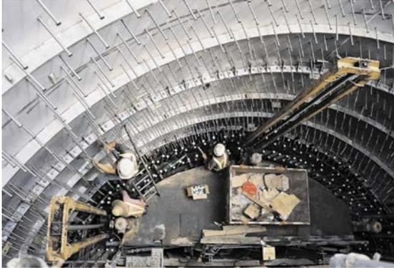
图片 5: 桥塔内的剪力连接件
